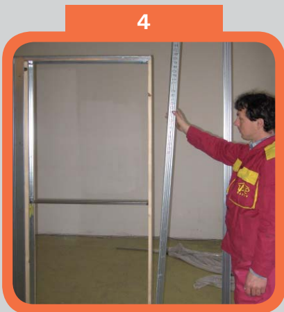
Montáž protilehlé strany konstrukce
