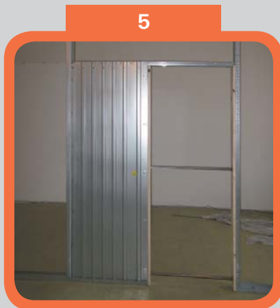
Usazené a zabudované pouzdro v konstrukci
