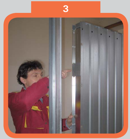
Přípevnění pouzdra ke konstrukci
