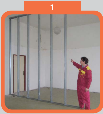
Příprava profilů SDK pro usazení pouzdra
